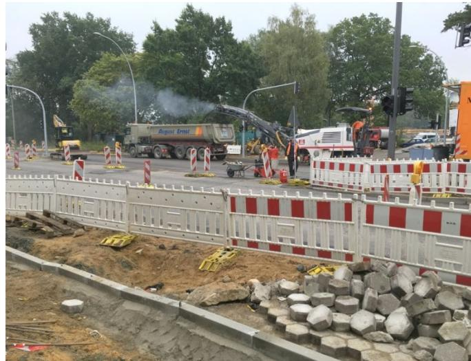
Um die Anbindung des Erschließungsgebietes NF 66 sicherzustellen, wurden zwei Knotenpunkte im Verlauf der B73 vollständig umgebaut und erweitert. Die Radverkehrsanlagen in den Knotenpunkten wurde anforderungsgerecht entsprechend der aktuellen Richtlinienlage umgestaltet. In diesem Zusammenhang wurden die Fußgängerführungen inklusiv ausgebildet und mit taktilem Leitelementen ausgestattet.
