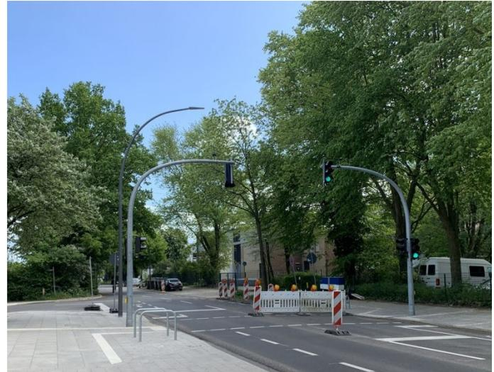
Aufgrund der veralteten Radverkehrsführung in der Tilsiter Straße zwischen der Lesserstraße und Voßkuhlen wurde die Verkehrsführung den heutigen Bedürfnissen angepasst und der Straßenquerschnitt zur Schaffung von entsprechenden Radverkehrsanlagen neu aufgeteilt.
