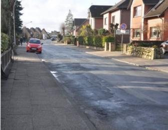
Die Landesstraße L160 befand sich in einem stark sanierungsbedürftigen Zustand. In Abstimmung mit dem LBV S-H NL Lübeck wurden die Straßenlage und der Querschnitt optimiert. Bislang versickerte das Straßenwasser in Sickerschächten oder unbefestigten Seitenbereichen. In diesem Zusammenhang wurde ein Regenwasserkanal DN400 bis DN700 neu verlegt. Die Länge des I. Teilbereichs beträgt 380 m. Der II. Teilbereich befindet sich derzeit in Planung. Die vorhandene Beleuchtung wird ersetzt.
