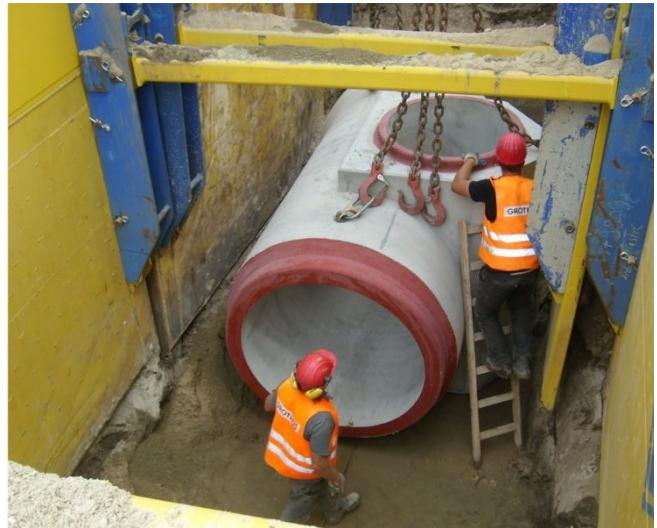
Neubau eines Regenwassertransportkanals auf der Luftseite des Flughafens Hamburg (im Flugsicherheitsbereich) auf einer Länge von 1.800 m. Durchmesser DN 800 bis DN 1.400. Der in einer Tiefe von 4 m bis 6 m herzustellende Kanal verläuft z. T. in unmittelbarer Nähe der Start- und Landebahn und von Rollwegen.
