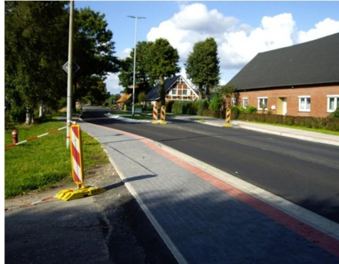
Die Maßnahme umfasst den Umbau der Ortsdurchfahrt Bevern im Zuge der Bundesstraße 71. Hierbei wurde der vorhandene Querschnitt mit beidseitigem Mehrzweckstreifen dahingehend umgebaut, dass neben der Fahrbahn beidseitig Radfahrstreifen ausgewiesen wurden. Auf diese Weise konnte der Radverkehr von den Fußgängern separiert werden. In kurzen Teilabschnitten wurden kombinierte Geh- und Radwege geplant.
