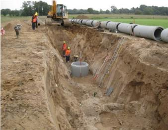
Die WAS erschließt im Rahmen des B-Plans 10B (GE Stapelfeld-Braak) ein neues Gewerbegebiet. Hierfür wurden Erschließungsstraßen, Regenwasser- und Schmutzwasserkanäle erforderlich. Aufgrund der unzureichenden Kapazität der Schmutzwasserableitung wurde ein System mit Rückhaltung von SW-Mengen in den morgendlichen und abendlichen Spitzenstunden erforderlich.
